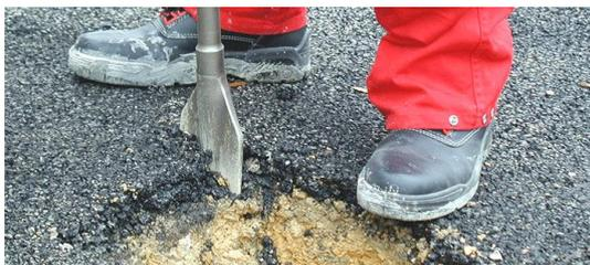
Viene utilizzato principalmente per lavori a terra, come la rimozione di rivestimenti plastici e bituminosi (resine) o per la demolizione di pavimenti. Può essere utilizzato anche per lavori di scavo grazie alla sua configurazione che ottimizza la posizione di lavoro e al ridotto tasso di vibrazione.
